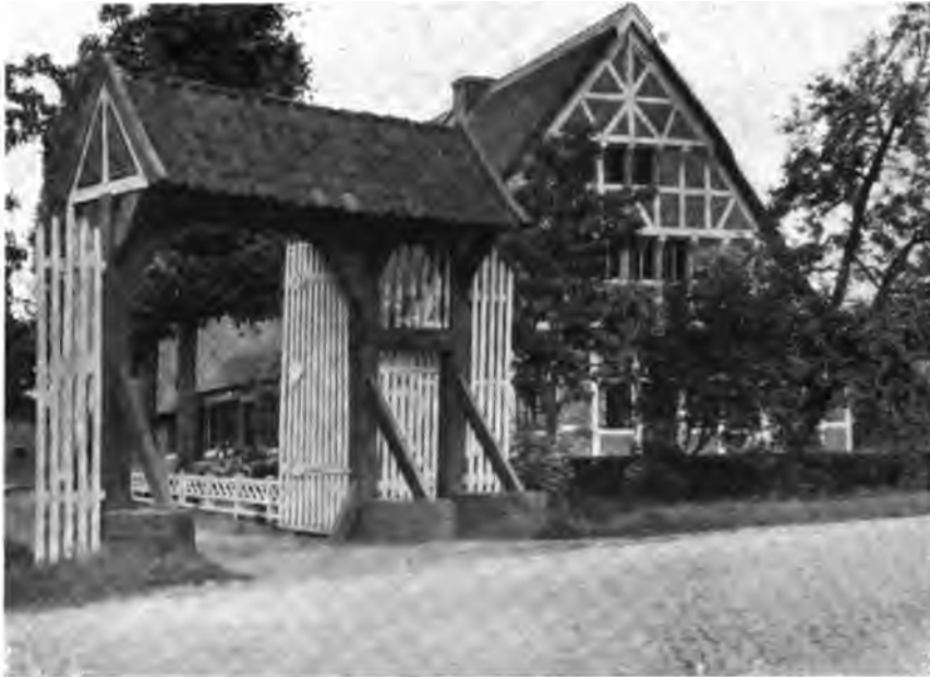
Toreinfahrt in Steinkirchen (Altes Land) Aufn. von Hans Much
