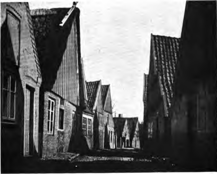
Straße in Söderau bei Krempe Aufn. von Hans Much
