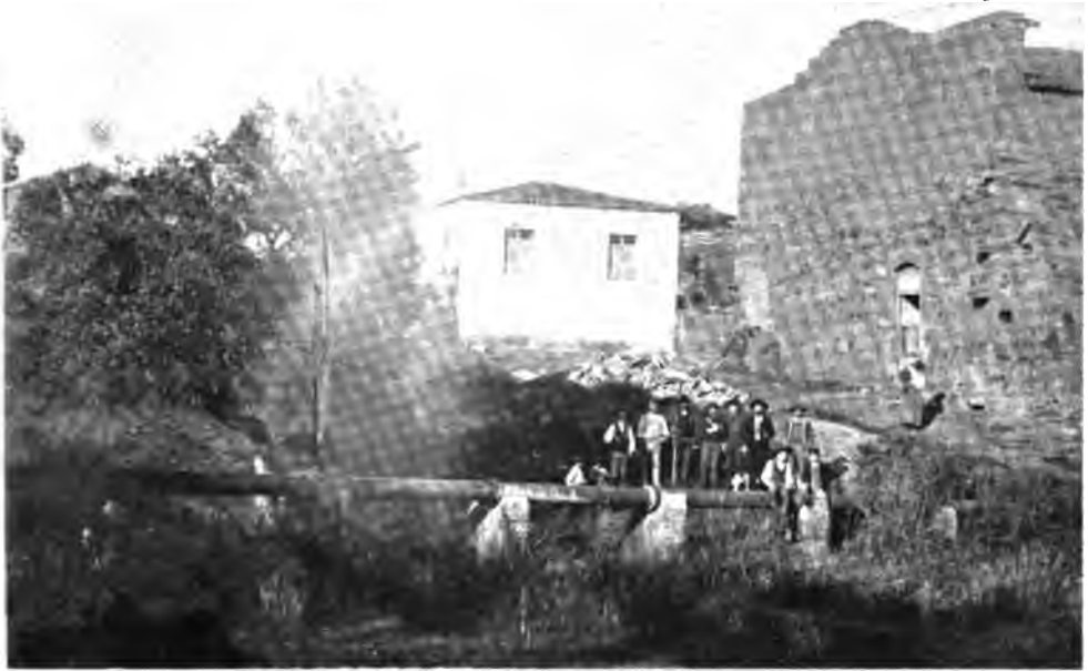
RESPIRADOURO NA CANALISAÇÃO D'AGUA DA FABRICA DE MOAGEM, NAS ENFERMIARIAS
