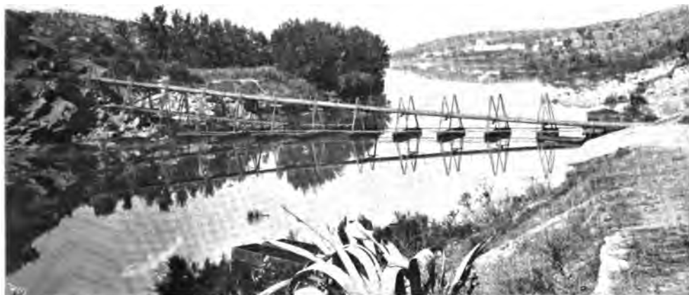
INSTRUÇÃO DE PONTONEIROS — PONTE DE EQUIPAGEM DE CAVALLETES SOBRE BARCOS
