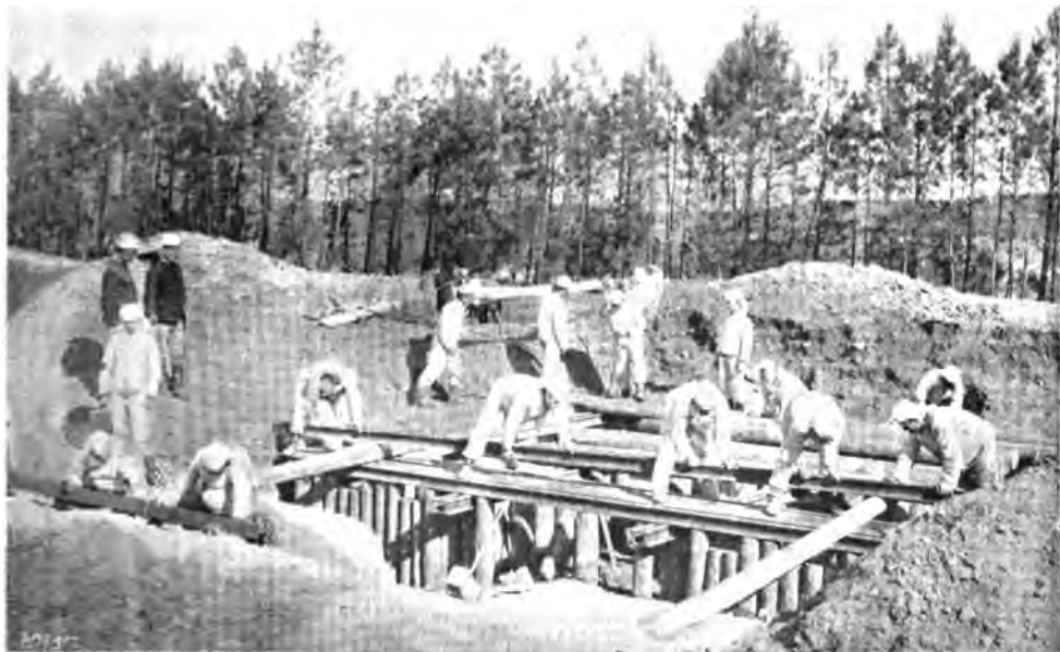
INSTRUÇÃO DE SAPADORES-MINEIROS — CONSTRUÇÃO DE UM ABRIGO BLINDADO
