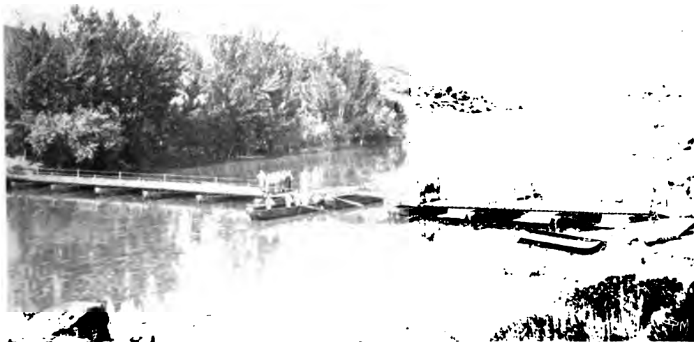
INSTRUÇÃO DE PONTONEIROS — SUBSTITUIÇÃO DE UM BARCO NUMA PONTE DE BARCOS DE EQUIPAGEM
